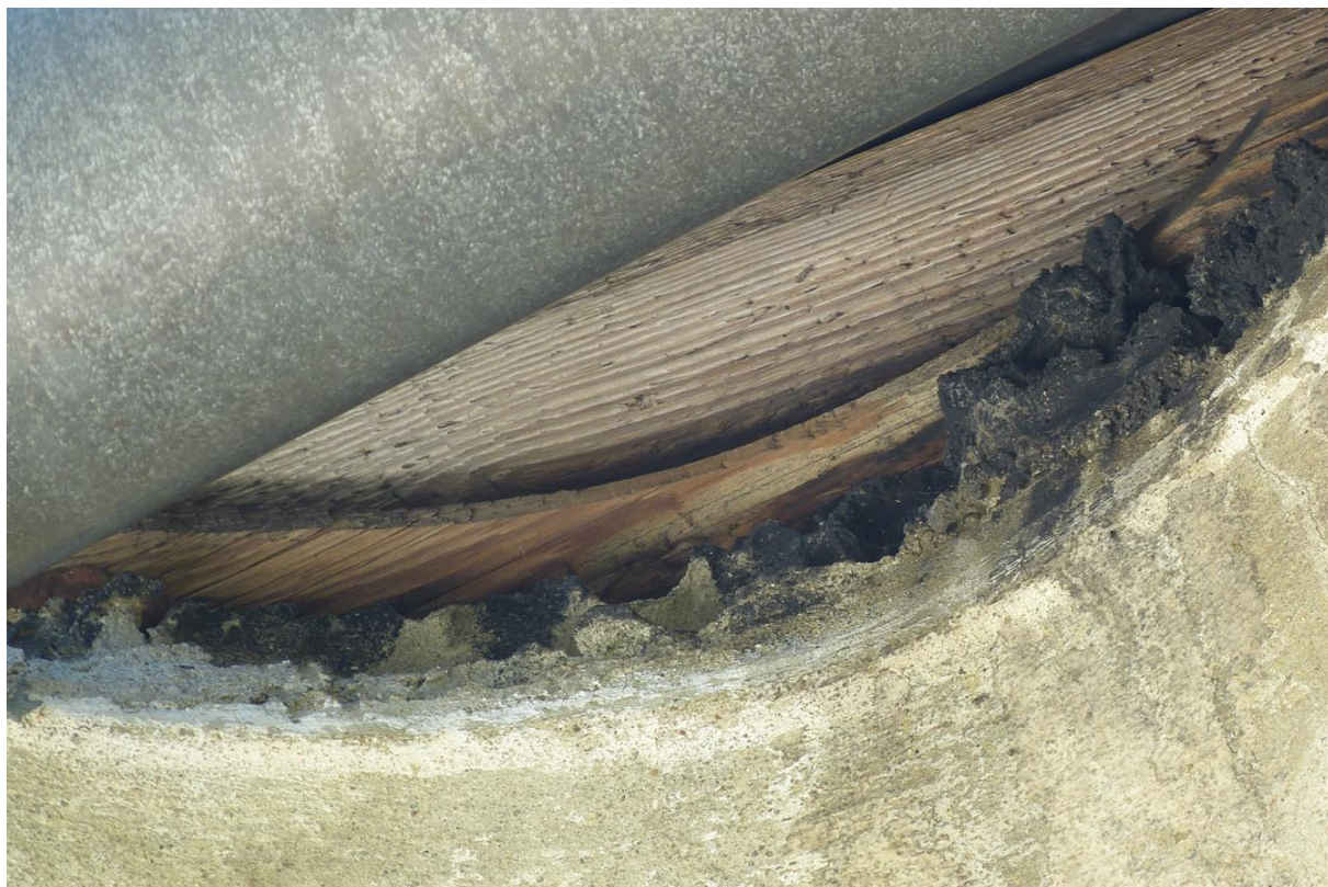
Fot. 6. Otwory w uszkodzonej podmurówce dachu i szczeliny podbitki, siedlisko nietoperzy.
